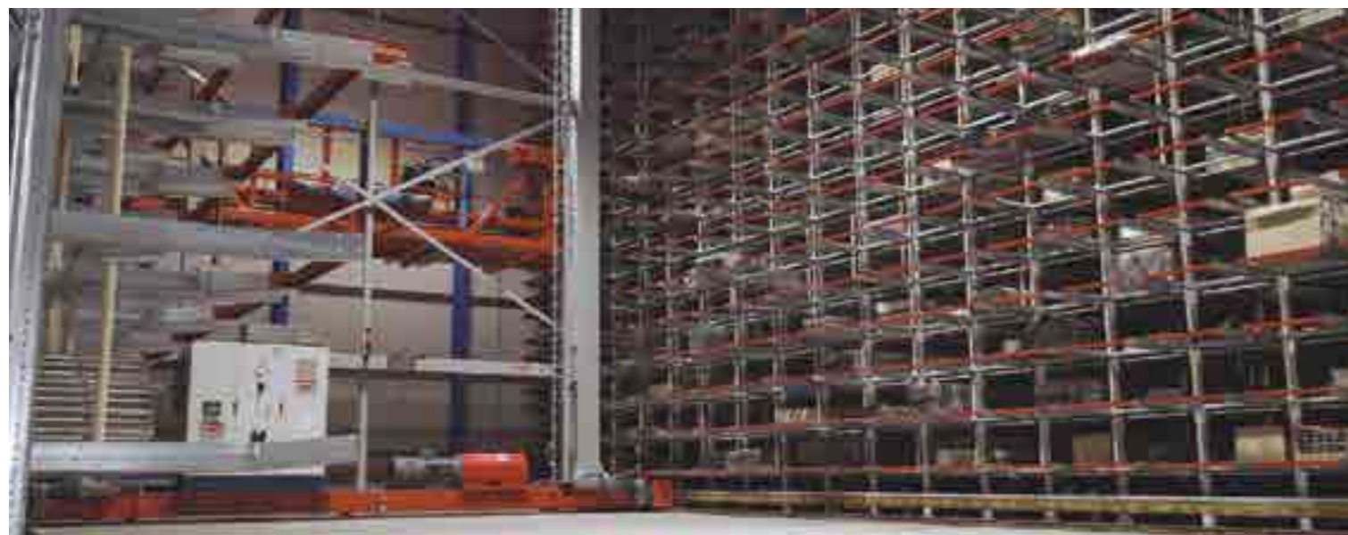
Magazzino automatizzato Automated warehouse
