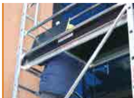
Con l'uso della botola si sale in sicurezza. Use the trapdoor to go up safer.
