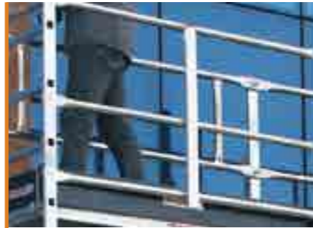
Rinforzo per parapetto. Reinforce for railing.
