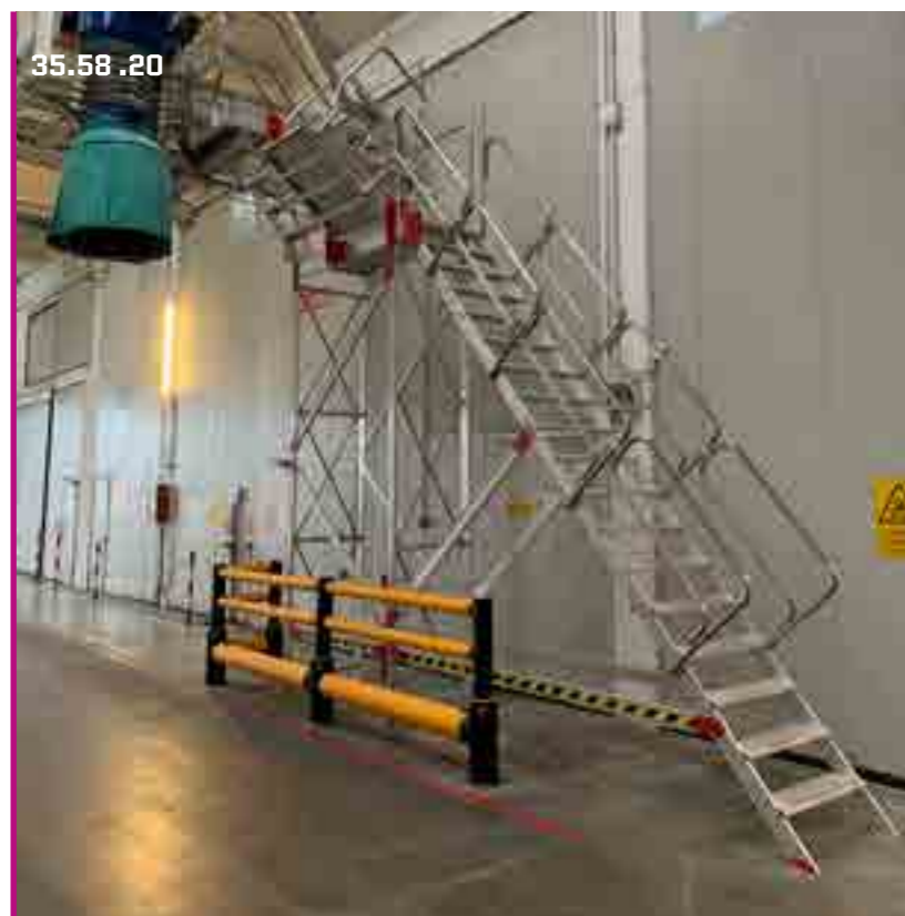
Scala System personalizzata per manutenzione sistema di carico elettronico per autocisterne Customized Scala System for maintenance of the electronic loading system for tankers.
