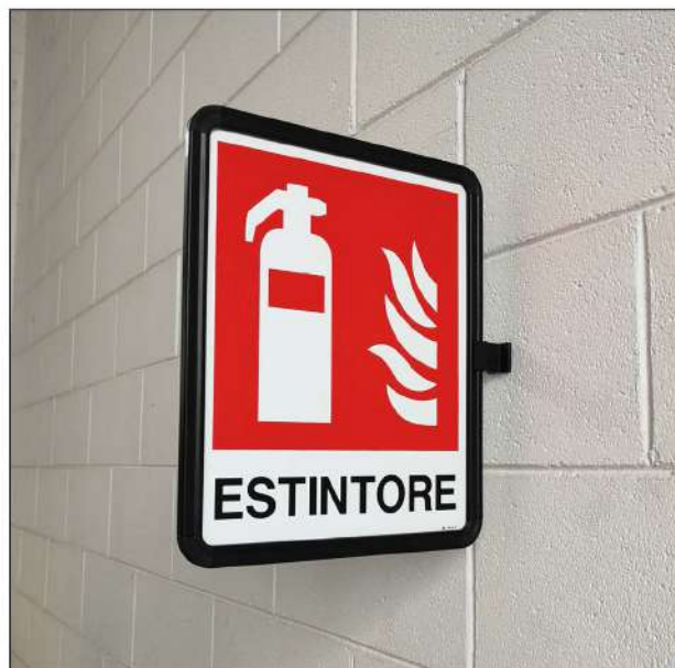
INSTALLAZIONE DI SEGNALI BIFACCIALI
