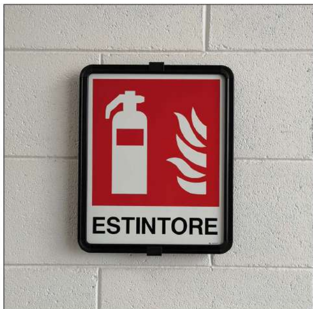
INSTALLAZIONE DI SEGNALI MONOFACCIALI
